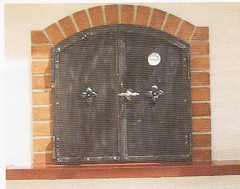
Dvířka do udicího prostoru s osazeným teploměrem
