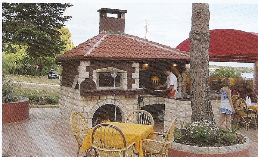
Obr. 53 Víceúčelová venkovní stavba pro přípravu jídel na ostrově Pag
