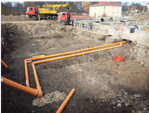
Obr.2 Pokládka zemního přehříváče
