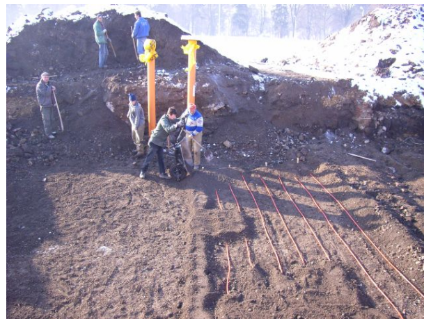
Obr.3 Pokládka registru pro tepelné čerpadlo
