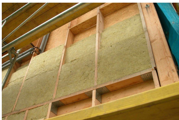
Zateplování dřevěného skeletu
