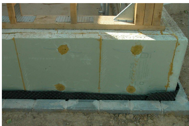
Odstranění tepelných mostů talířových kotev a lepení vrstev XPS pomocí PU pěny
